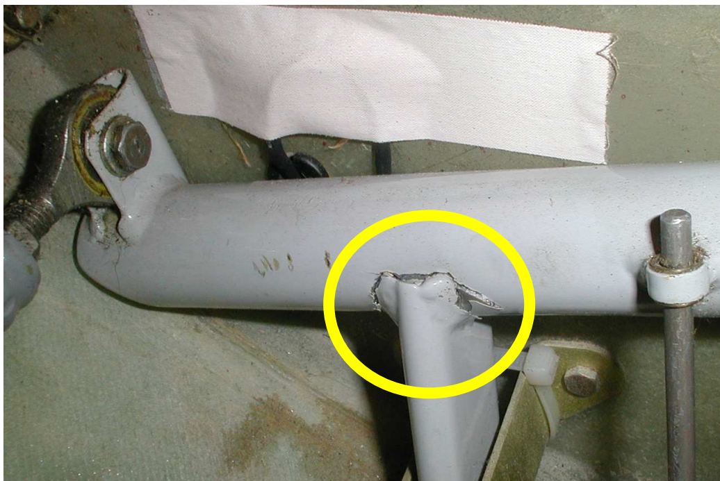
Abbildung 4: Schaden von hinten
